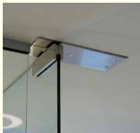
Ganzglastür mit Zapfenbändern und Türschließer.
