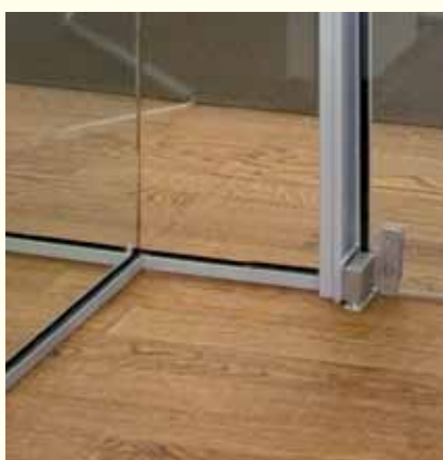
T-Verbindung mit Silikonfuge.
