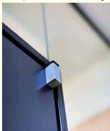
Zapfenband in T-Profilzarge.
