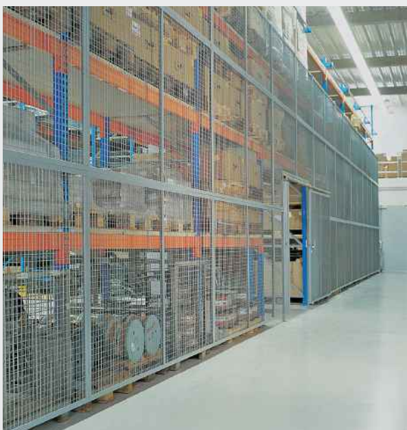
Gitterwände als Absturzsicherung und zur Absicherung der Lagerbereiche.
