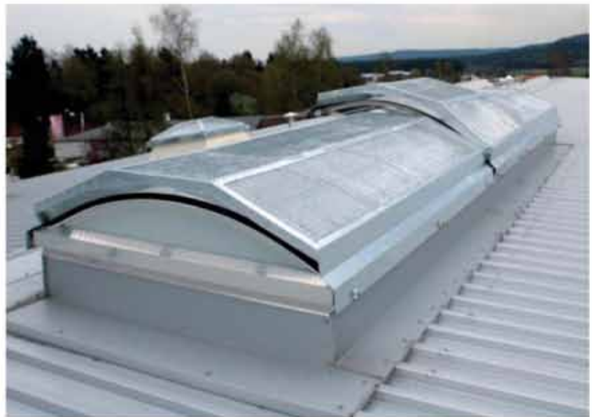
Lichtbandschutz mit Lüftungs- oder Rauchabzugsklappe
