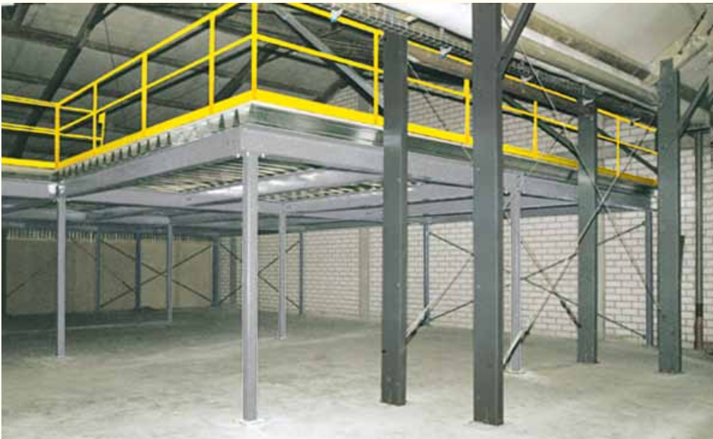
Lagerbühne im Aufbau mit rückseitigen Windverbänden
