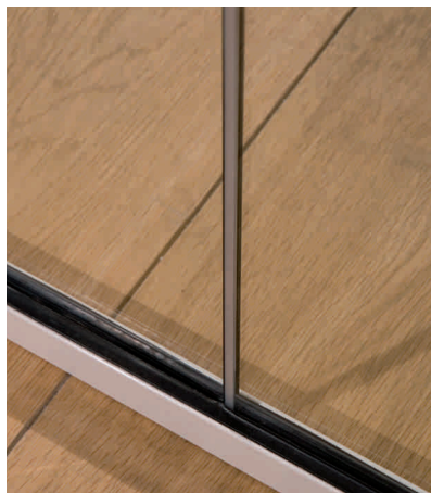
Verbindung mit Silikonfuge
