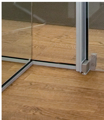
T-Verbindung mit Silikonfuge
