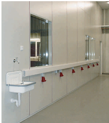
Bild oben: Strom- und Sanitärinstalla- tionen
