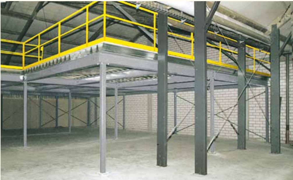
Lagerbühne im Aufbau mit rückseitigen Windverbänden
