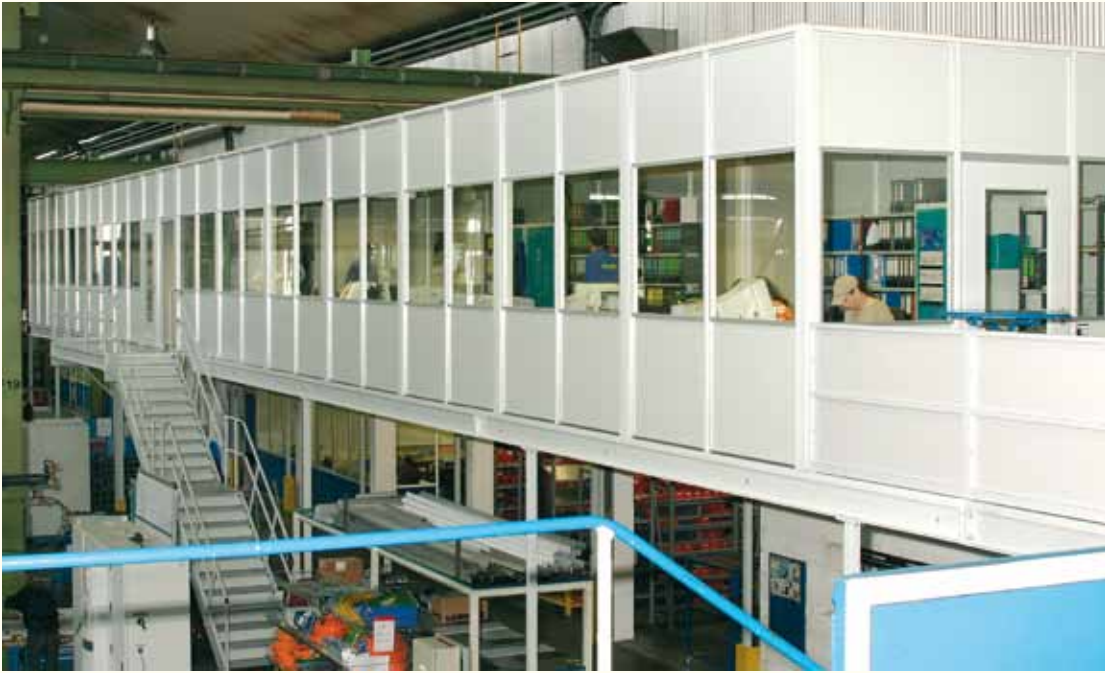
Bühne mit integrierten Büros über dem Produktionsbereich
